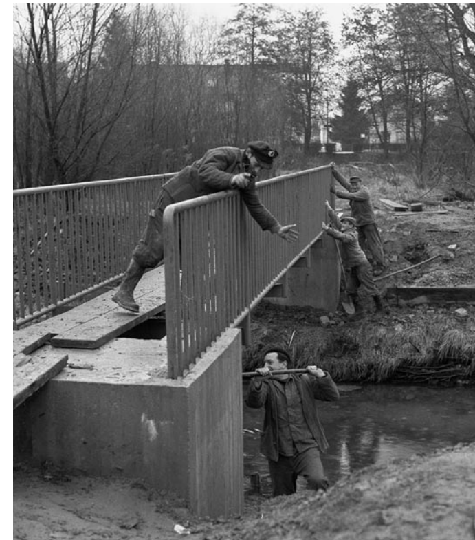
Bau der Fußgängerbrücke über den Reiherbach 1962 © Stadtarchiv Karlsruhe 8/BA Schlesiger A9a/257/4/1
