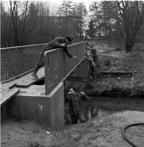
Bau der Fußgängerbrücke über den Reiherbach 1962
